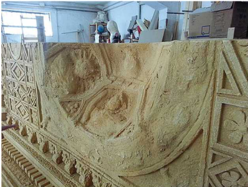
Patrimonio recuperato I lavori di ricostruzione del soffitto del Tempio di Bel a Palmira, in Siria, distrutto dai miliziani di Isis nell'agosto 2015. L'opera, che ha riguardato una porzione di 4,2 metri per 2,5, è a grandezza naturale
